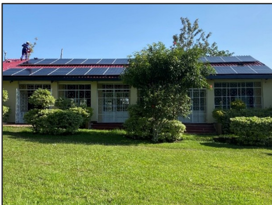
Fase 1: Installatie van 30 zonnepanelen aan de achterkant van de trainingshal voltooid
