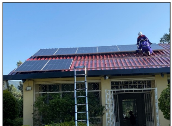
Fase 2: Installatie van 30 zonnepanelen aan de voorkant van de trainingshal in volle gang
