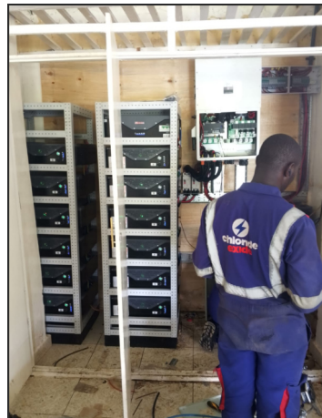
Arbeider van Chloride Exide aan het werk bij het installeren de batterijen
